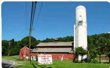
Silos y depósitos
